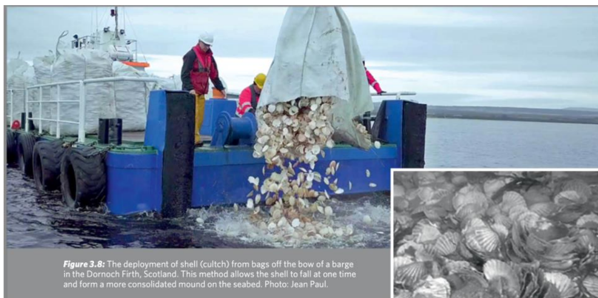
Figura 4. Utilizzo di valve o conchigliame (cultching) per creare un substrato idoneo all'insediamento di banchi di ostriche in Scozia (Dornoch Firth) (Helmer et al., 2020).
